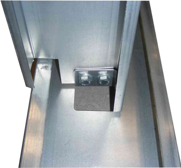
1.3 Bina Ara Kat Karkası
